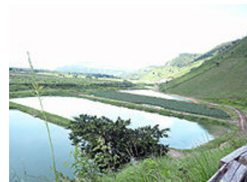
Sistema de bio-filtros.
