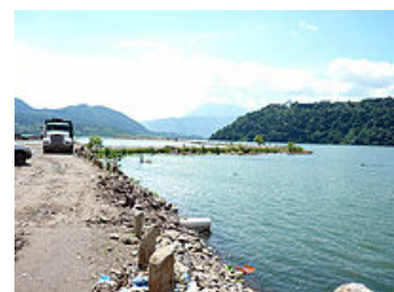
Lagunas de tratamiento en el estuario.
